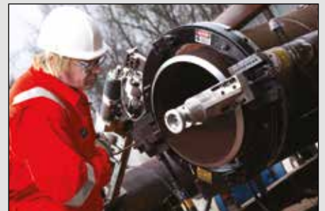
▲ Rohrschneider und Schweißvorbereitung.
