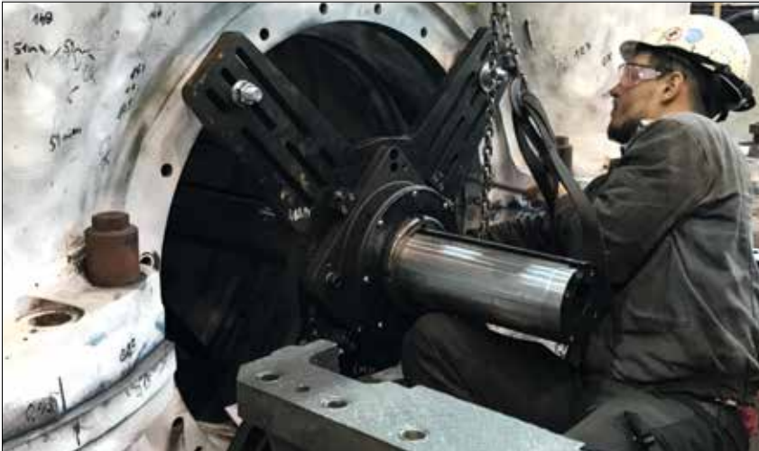
▲ Rohrschneider und Schweißvorbereitung.
