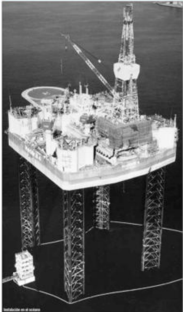
Instalación en el océano
