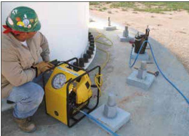
◀ *La bomba ZUTP-1500 es resistente, ligera, compacta para aberturas estrechas y asegura un tensado de tornillos sin problemas en lugares remotos dos veces más rápido que bombas competitivas.*
