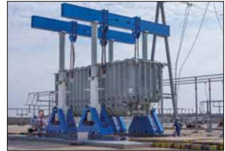
Präzises Anheben und Positionieren von schweren Lasten
