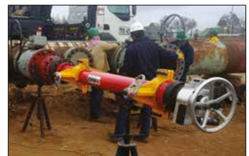
▲ CHT3000 Hot-Tapping-Anwendung für Installation von petrochemischen Rohrleitungen.
