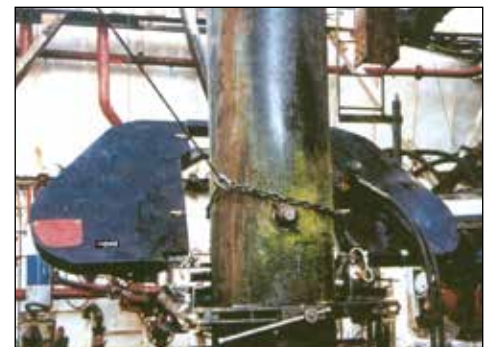
▼ Abbrucharbeiten mit Bandsäge.
