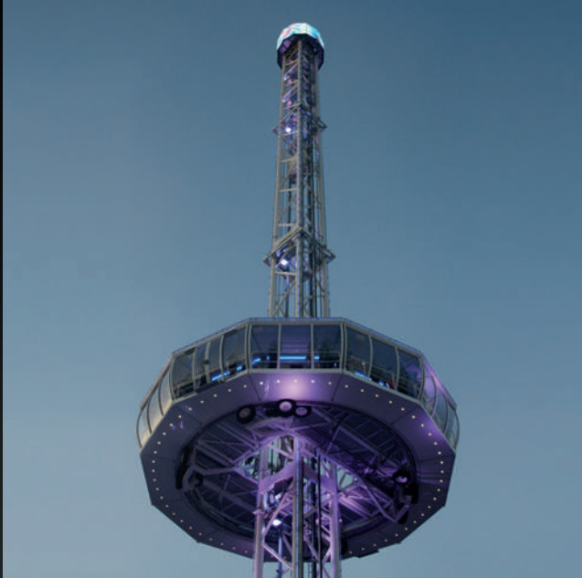
In den Antrieben der mobilen Aussichtsplattform City Skyriser aus den Niederlanden.
