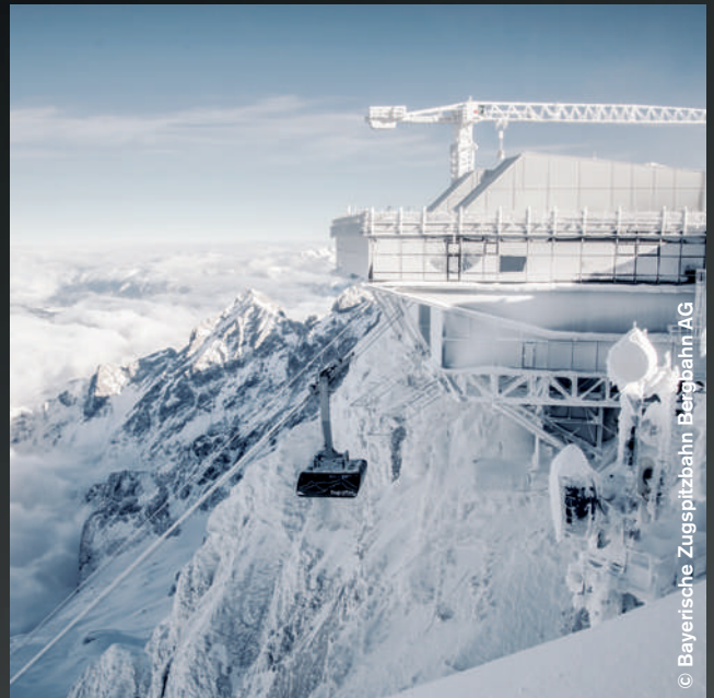
Im Antrieb der neuen Seilbahn Zugspitze in Deutschland.
