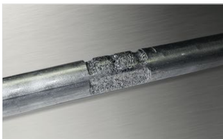
Spaltkorrosion unter einem üblichen Schellenkörper
